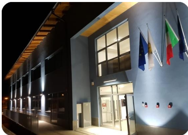
Figura 1 - Sede del Plesso di Tramutola
